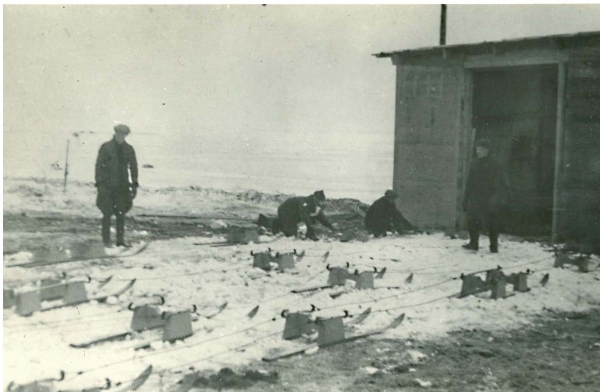
Лыжи, которые использовали при ремонте кабелей
