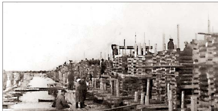
Строительство пирса в Кобоне
