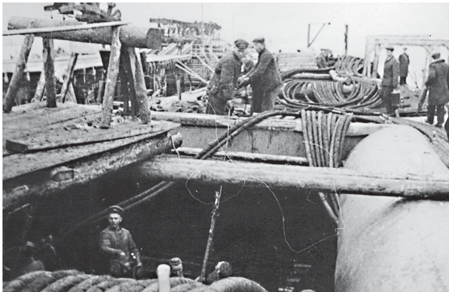
Самая трудная часть намотки происходила в трюме: 15 человек с усилием располагали кабель по всему периметру. За восьмичасовую смену наматывали до 10-ти барабанов, а это почти пять километров!
