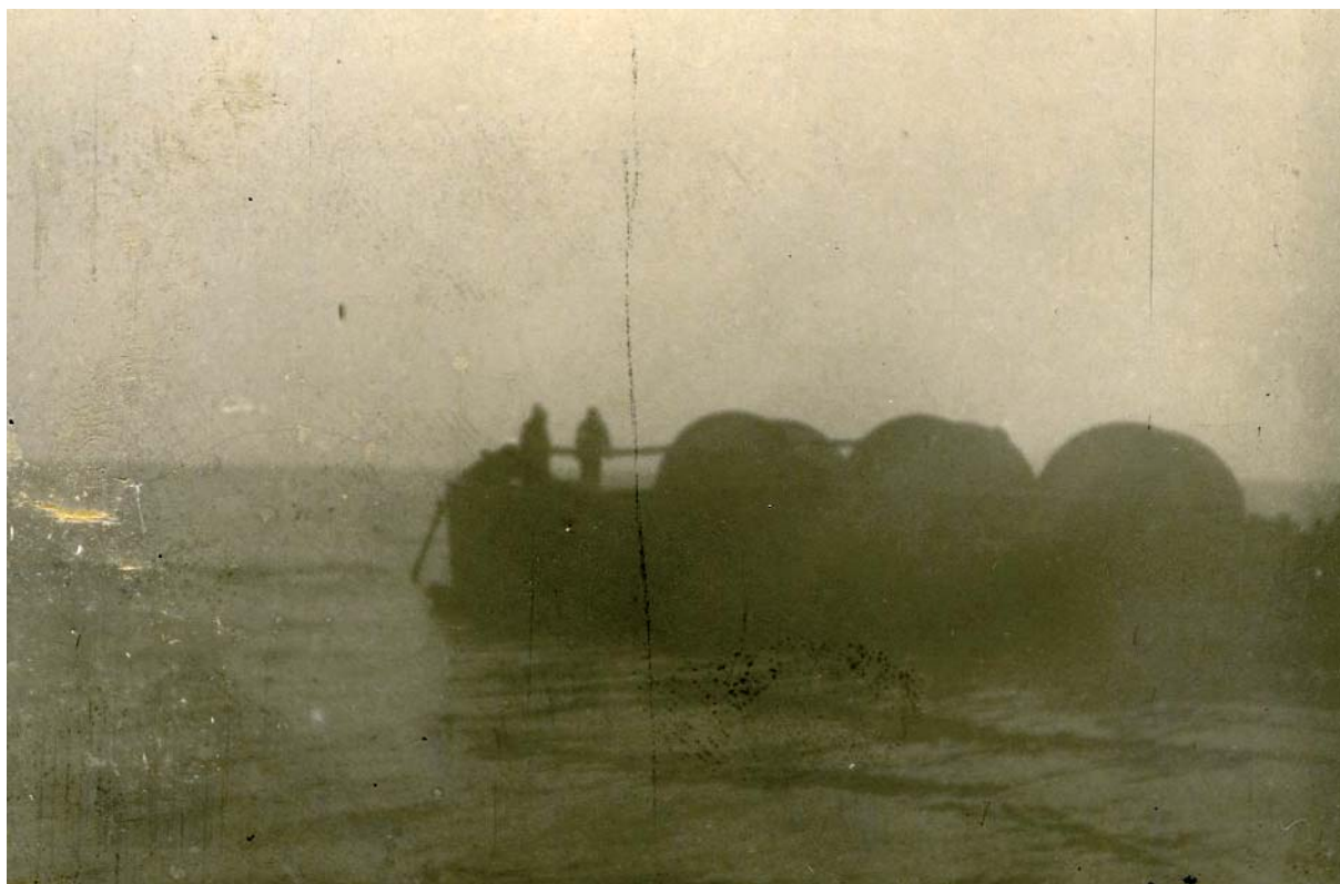
Спуск кабеля в Ладожское озеро
