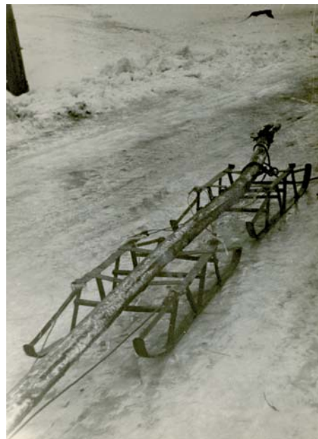
Санки с кабелем, который тащили по льду для ремонта
