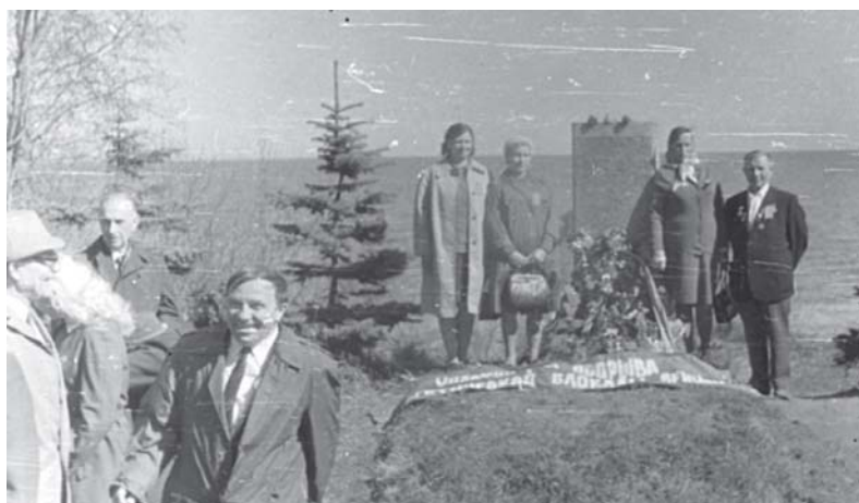
Ветераны Специального кабельного района ЛКС у обелиска в месте выхода подводного кабеля. Ладога, май 1975 г.
