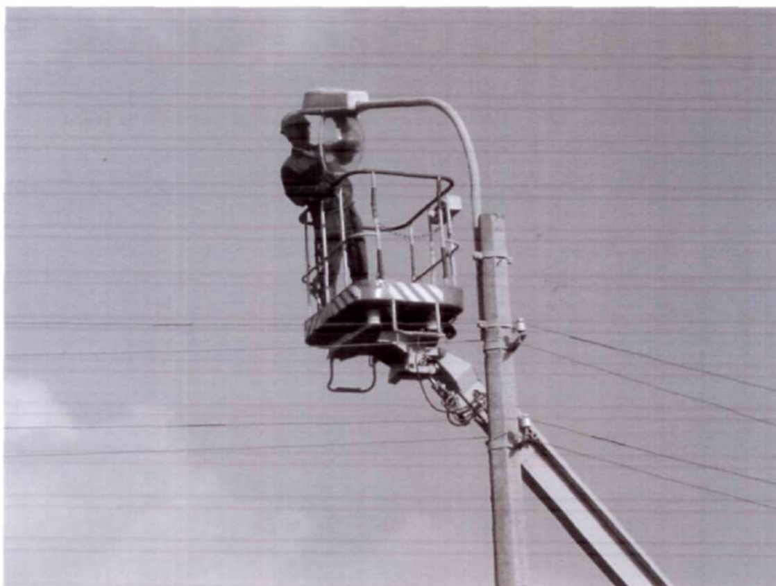
Электромонтер бригады ВЛ при замене лампы в светильнике
