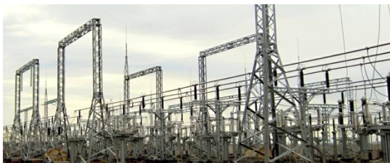
КМ-ОРУ – 110 кВ на ПС Елабуга 500 кВ
